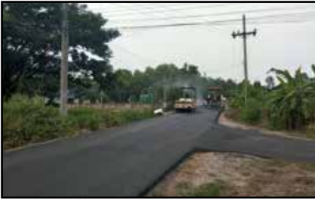
ปรับปรุงผิวถนนคอนกรีตโดยปูแอสฟัลต์ติกคอนกรีต หมู่ 3, 4, 9 และ 16
