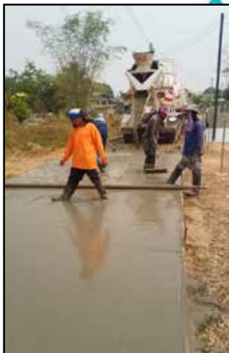
ก่อสร้างถนนคอนกรีตเสริมเหล็ก (ค.ส.ล.) ในหมู่บ้าน หมู่ 15 บ้านเกษตรสุข
