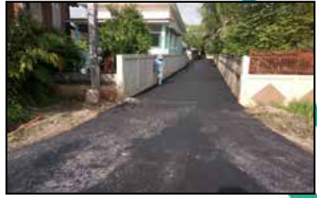
ปรับปรุงผิวถนนคอนกรีตโดยปูแอสฟัลต์ติกคอนกรีต หมู่ 3, 4, 9 และ 16
