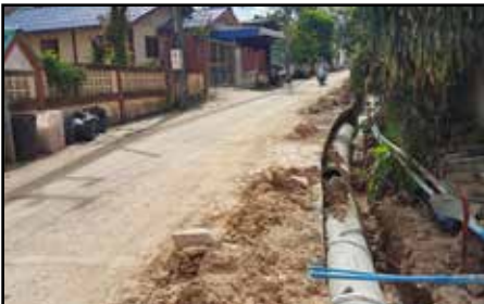
วางท่อ (ค.ส.ล) พร้อมบ่อพัก ซอย 4 หมู่ 16 บ้านแม่กาหัวเขื่อน
