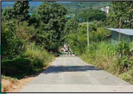
ก่อสร้างถนนคอนกรีตเสริมเหล็ก (ค.ส.ล.) หมู่ 1 บ้านหม้อแกงทอง
